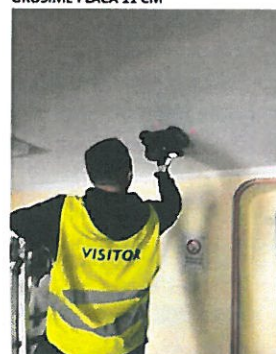
28) PAHOM /RADAR PLANSEU PL2 ET 1 - PLASA BARE 8 MM / 20 CM CM - GROSIME PLACA 11 CM
